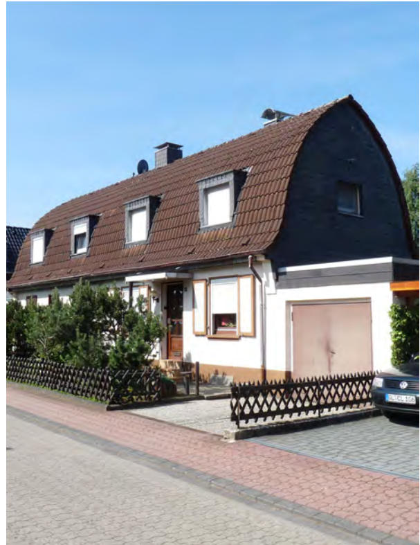
Abb. 22 Doppelhaus mit Tonnendach
