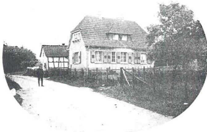
Fig. 18. Kleinwohnungshaus in Bergisch-Gladbach. Architekt Will.
