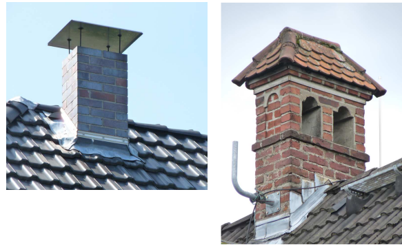
Aufgemauerter Schornstein mit einfacher Meidinger Scheibe
