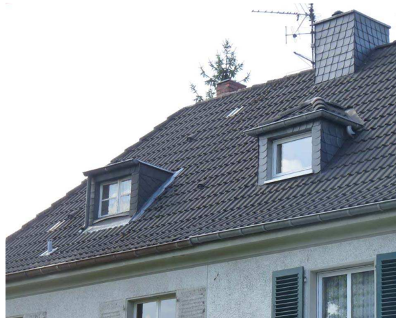
Flachdach und Walmdachgaube
