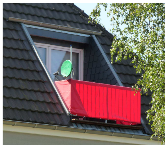
Dacheinschnitte in Form von Loggien sind für die Siedlung untypisch
