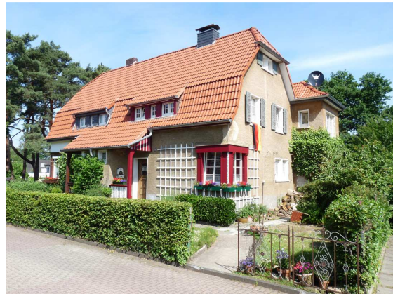
Beispiel für eine Neueindeckung mit naturroten Doppelmuldenpfannen.
