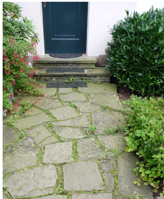
Eingangsstufen und Belag aus Grauwacke-Platten
