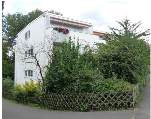
Gebäude mit Staffelgeschoss verunklären die bauzeitliche Gestaltidee
