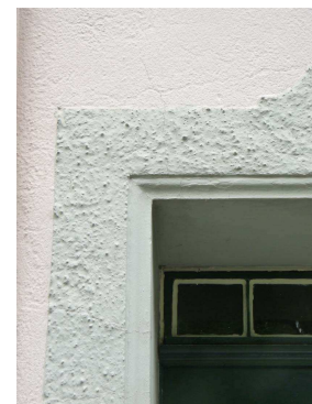
Stuckgewände als gliederndes Element für den Eingangsbereich.
