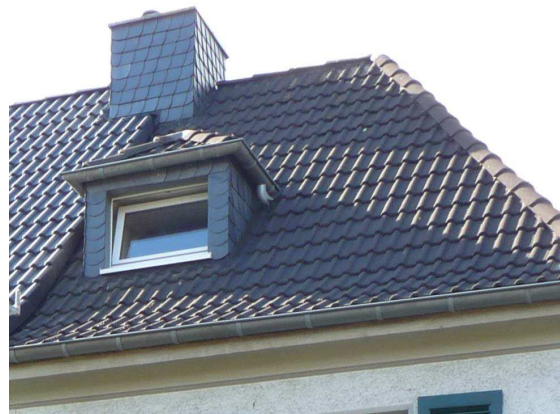
Nicht angepasste Sanierung eines Doppelhausdaches.
