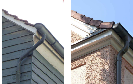
Ursprüngliches Ortgangdetail mit Stirnbrett und Ortgangpfannen
