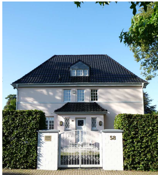
Renoviertes Beamtenwohnhaus mit Putzfassade und Gesimsgliederung.
