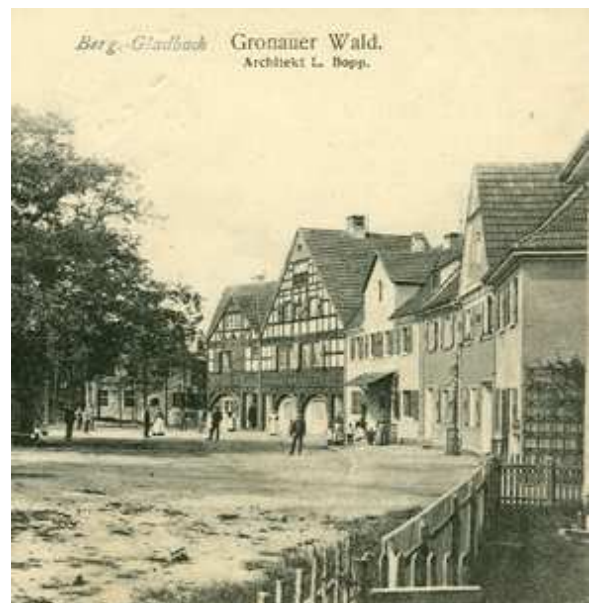
Dachlandschaft im Bereich „An der Eiche“
