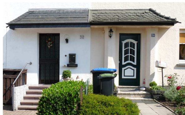
Türen wurden je nach der Vorstellung der Nutzer eingebaut und stören das Gesamterscheinungsbild
