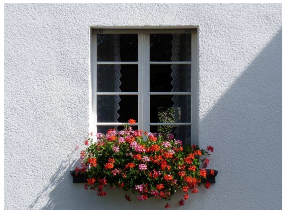
Stimmige Fensterproportionen mittels nicht sichtbarem Rollladenkasten
