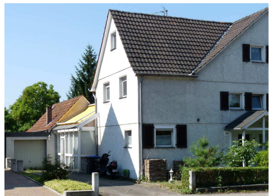
Anbau nimmt die vorhandenen Gestaltungsmerkmale nicht auf
