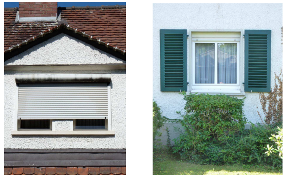
Veränderte Fensterproportionen durch nachträglich eingebaute Rollladenkästen
